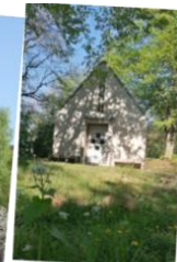
Josefkapelle auf der Wilhelmshöhe
